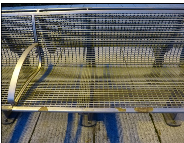
Abbildung 12: Fast alle Bänke auf dem Bahnsteig in Aumühle weisen Roststellen auf.
