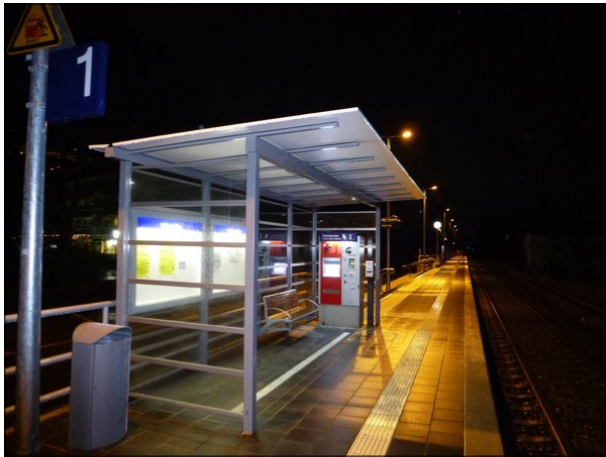
Abbildung 1: Am 14.12.2014 wurde die neue Station Kronshagen in Betrieb genommen.
