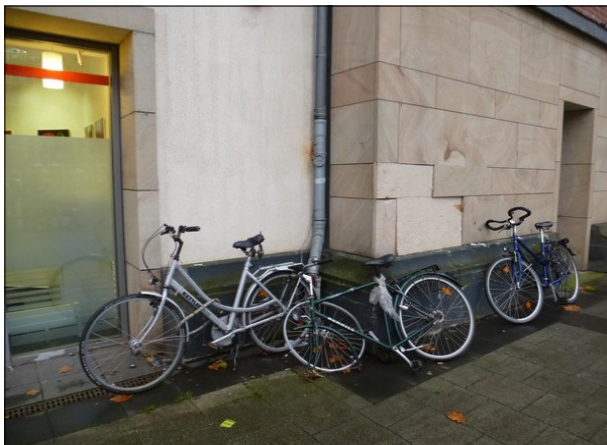
Abbildung 50: Am Empfangsgebäude des Kieler Hauptbahnhofs beeinträchtigen einzelne Schäden an der Fassade und an abgestellten Fahrrädern das Erscheinungsbild.
