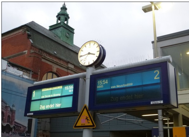
Abbildung 16: Der Zugzielanzeiger im Außenbereich an Gleis 2 in Lübeck Hbf war nicht vollständig hinterleuchtet.
