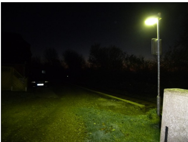
Abbildung 47: In Maasbüll war dieser Lichtmast die einzige Beleuchtung. Da die Lichtquelle im Unterstand nicht funktionierte war dieser an anderen Bahnsteigende gar nicht erkennbar.
