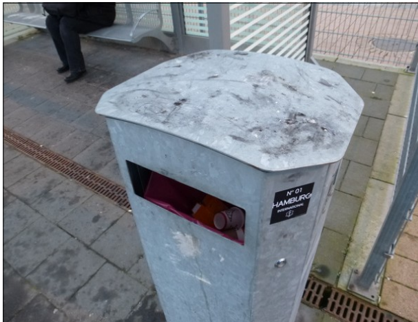
Abbildung 13: Durch den Verzicht auf eine Beschichtung verschmutzen die Behälter am Bahnhof Heide relativ schnell.
