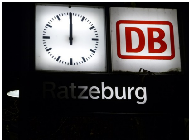
Abbildung 25: Neben der Uhr fiel am Stationsmast in Ratzeburg auch ein Teil der Beleuchtung des Bahnhofschildes aus.
