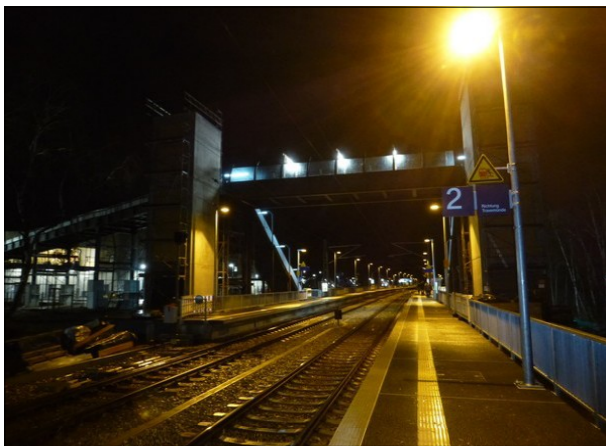
Abbildung 2: Ebenfalls seit dem 14.12.2014 halten Nahverkehrszüge am Bahnhof Lübeck-Dänischburg IKEA. Zur Inbetriebnahme waren die Aufzüge noch in Bau, und es gab keinen Entwerter.
