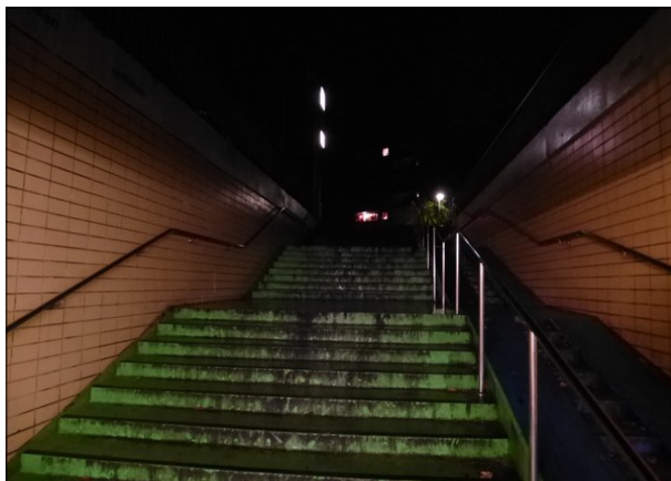
Abbildung 48: Wie schon vor einem Jahr waren beide Lichtmasten an der Treppe des Ausgangs Ostereschweg in Halstenbek defekt.
