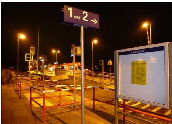
Abbildung 30: Eine Verbesserung stellt diese neue Vitrine mit dem Abfahrtsplan am Zugang zum Bahnsteig in Lauenburg dar.
