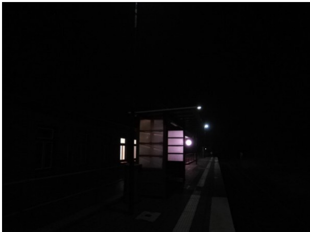
Abbildung 8: Unverändert schwach ist die Beleuchtung des Bahnsteigs in Hademarschen. Da die Beleuchtung des Unterstands erneut nicht funktionierte war das ein erheblicher Mangel. Auch die Aushänge in der Vitrine des Unterstands waren so nicht lesbar.
