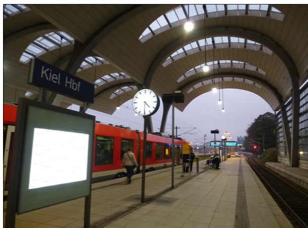
Abbildung 21: Während die Vitruinbeleuchtungen Ende 2013 an den Strom angeschlossen wurden, sind alle Bahnhofsnamensschilder im Kieler Hauptbahnhof weiterhin unbeleuchtet.
