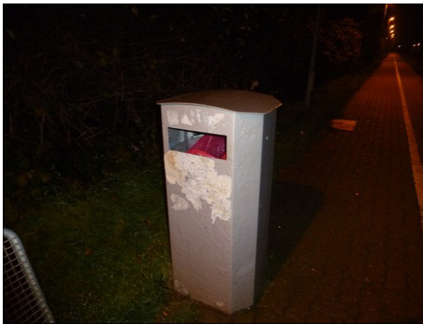
Abbildung 14: Großflächig abgeplatzter Lack führt zu Rostbildung an diesem Müllbehälter in Nortorf.
