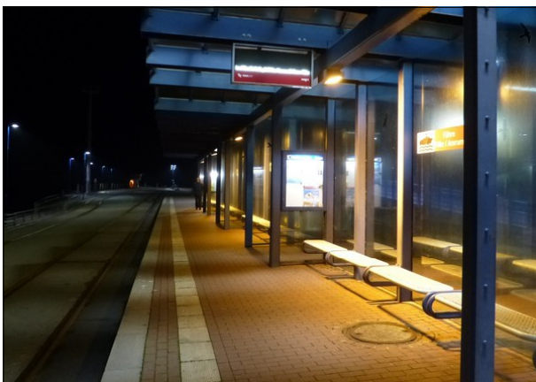
Abbildung 18: In Dagebüll Mole wurde erstmalig ein Zugzielanzeiger installiert. Er befand sich allerdings noch im Testbetrieb und zeigte keine aktuellen Informationen an.
