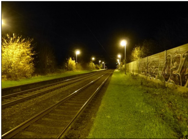
Abbildung 23: Die im Sommer errichtete Lärmschutzwand an der Station Kupfermühle war im Winter schon großflächig beschmiert.
