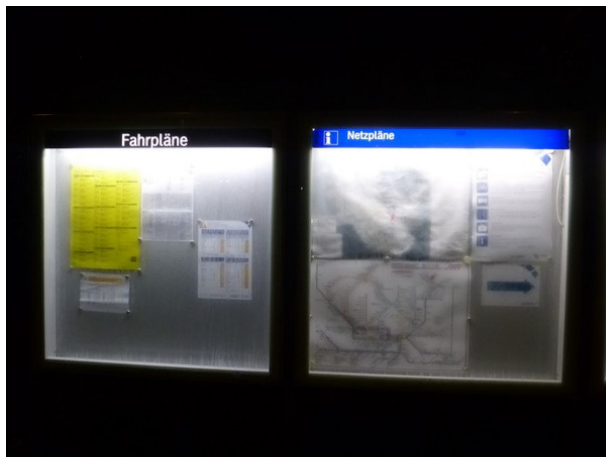
Abbildung 31: Auch die Netzplanvitrine in Bad Segeberg an Gleis 2 war innen stark beschlagen.
