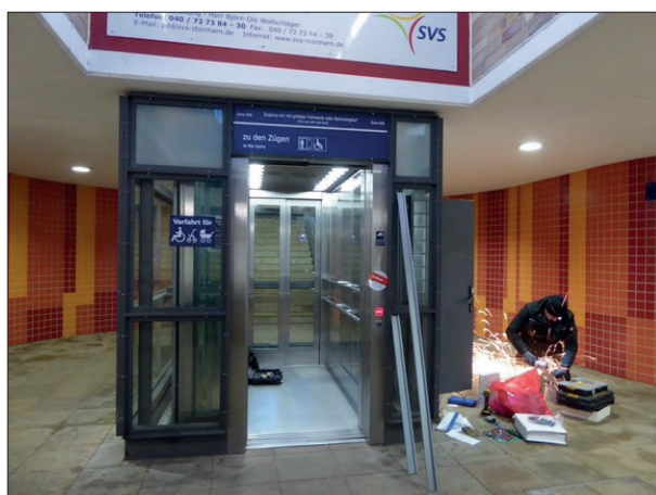
Abbildung 57: Für die Reparatur des Aufzugs zum Bahnsteig in Reinbek mussten vor Ort Ersatzteile angepasst werden.
