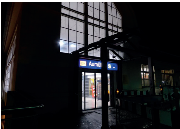
Abbildung 51: Seit mehreren Jahren ist die Leuchte unter dem Vordach am Eingang des Bahnhofs Aumühle defekt. Eine Instandsetzung würde den Bereich deutlich aufwerten.
