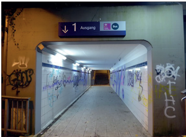
Abbildung 26: Umfangreiche Schmierereien prägten die Unterführung in Raisdorf.
