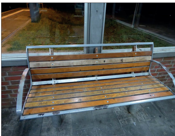
Abbildung 15: Die Bänke in Lensahn weisen neben den fehlenden Latten auch Lackschäden mit Rostbildung auf.
