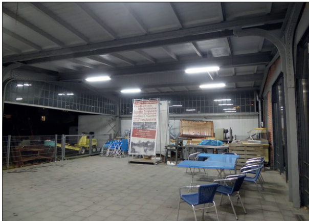
Abbildung 58: Der Sperrmüll unter dem Vordach des Bahnhofsgebäudes von Lübeck-Travemünde Strand beeinträchtigt das Erscheinungsbild.
