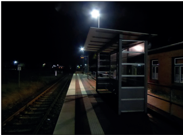
Abbildung 10: Nicht einmal ein Jahr hat die durch ein Solarpanel versorgte Beleuchtung des Unterstands in Hademarschen funktioniert. Ohne Beleuchtung sind auch die Aushänge in der Vitrine nicht lesbar.
