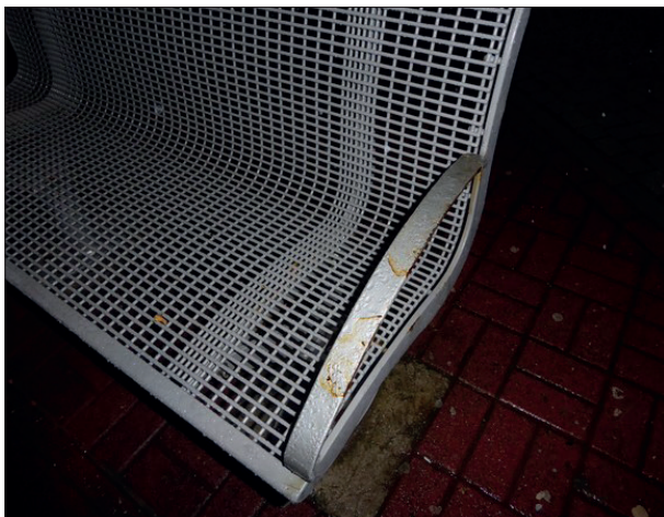
Abbildung 14: An dieser Bank in Bad St. Peter Süd ist gut zu erkennen, dass ein Überstreichen die alten Lackschäden nur kurzzeitig verdeckt.
