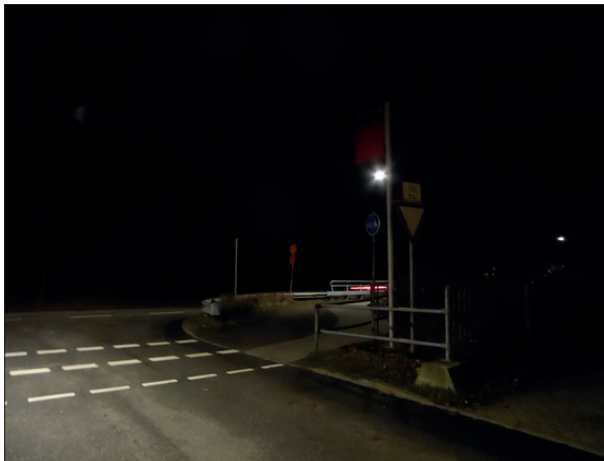
Abbildung 29: Ohne Beleuchtung fällt der Stationsmast in Scharbeutz bei Dunkelheit nicht auf.
